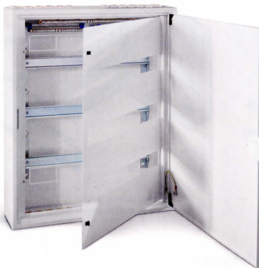
► MSN – dveře i kryty modulů le otvírat vlevo i vpravo
